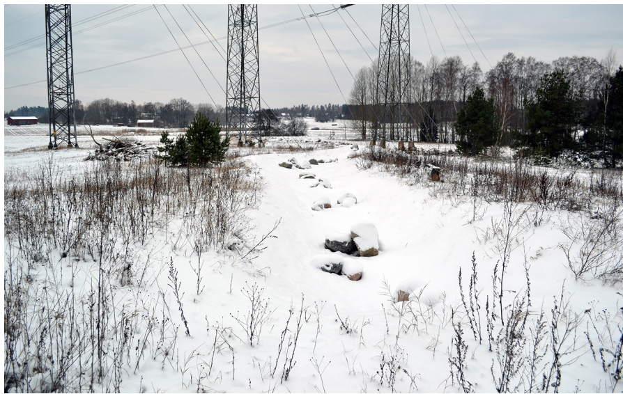
↑ Tvättvattnet som används för att rena bergmassorna från kväve ska pumpas till reningsdamarna via en konstgjord å. Stenarna på botten är placerade för att ge vattnet rörelse.
